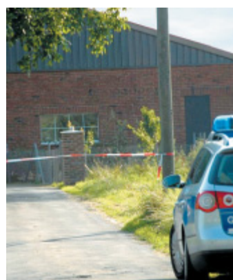
Abgesperrt: Die in mehrere Räume unterteilte Scheune des Hofes in Rheda.
